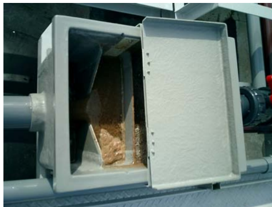
▲ 新設、沈殿槽及びNo6曝気槽各配管、計量槽
