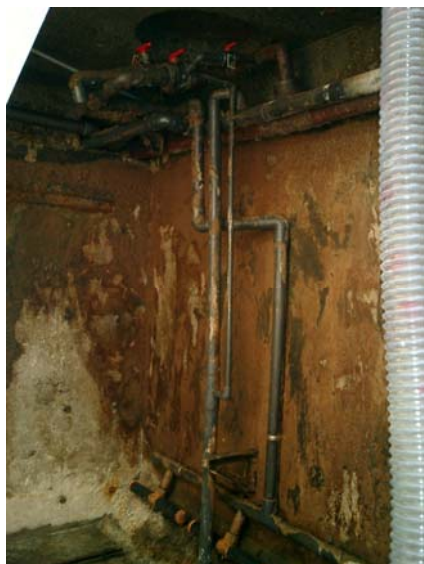
▲ No1曝気槽内部(ハーネット撤去後)
