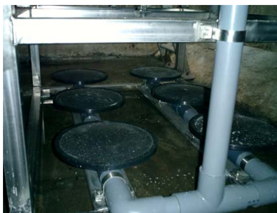
▲ 新設、散気盤デフューザー(1ユニット/6枚装備)
