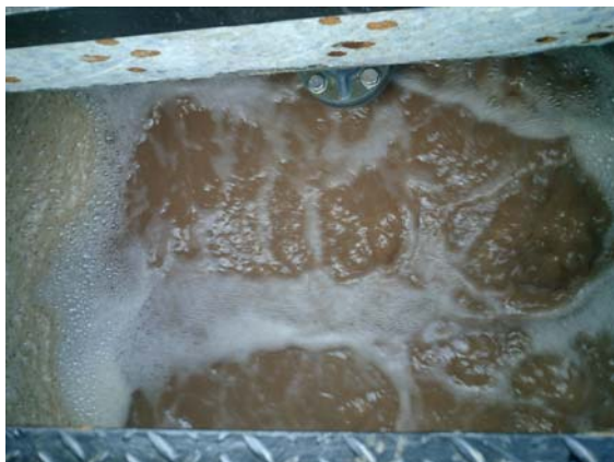
▲ No1接触曝气槽、注水完了 曝气開始
