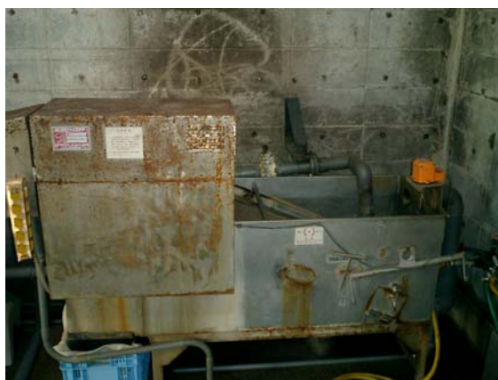
▲ 既設、濾布スクリーン
