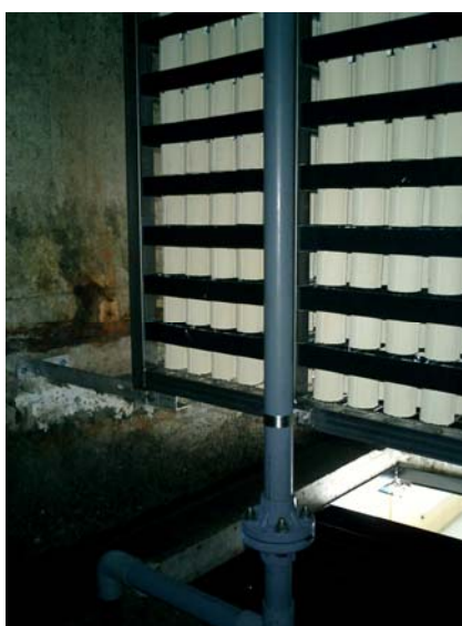
▲ 新設、ポラスソフトセラミックユニット (1ユニット/1800本装備)
