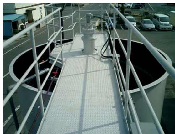
▲ No6沈殿槽上点検デッキ
