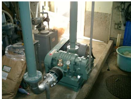
▲ 新設、曝気ブロー-BS-80 5.5Kw-30kpa
