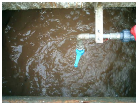
▲ No1接触曝气槽、注水完了 曝气開始
