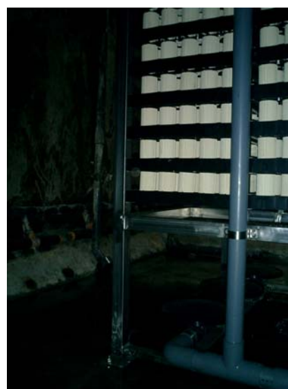
▲ 新設、散気盤デフューザー(1ユニット/6枚装備)
