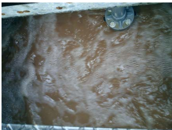
▲ No1接触曝气槽、注水完了 曝气開始
