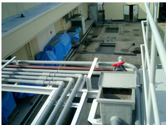
▲ 新設、沈殿槽及びNo6曝気槽各配管、計量槽
