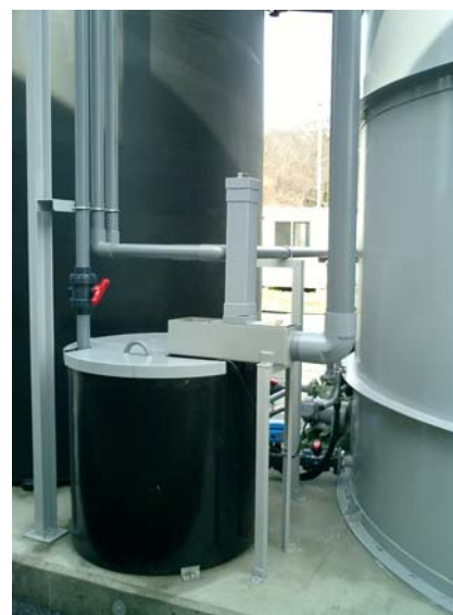
▲ 新設、排水放流槽
