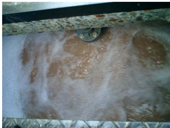
▲ No1接触曝气槽、注水完了 曝气開始
