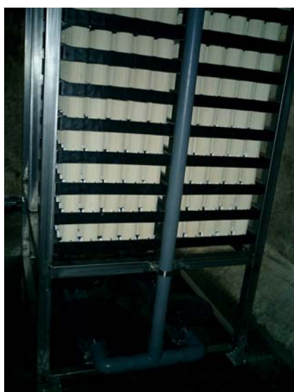
▲ 新設、ポラスソフトセラミックユニット (1ユニット/1800本装備)
