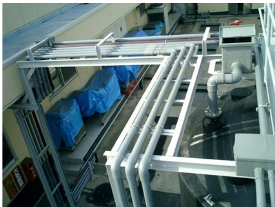
▲ 新設、沈殿槽及びNo6曝気槽各配管
