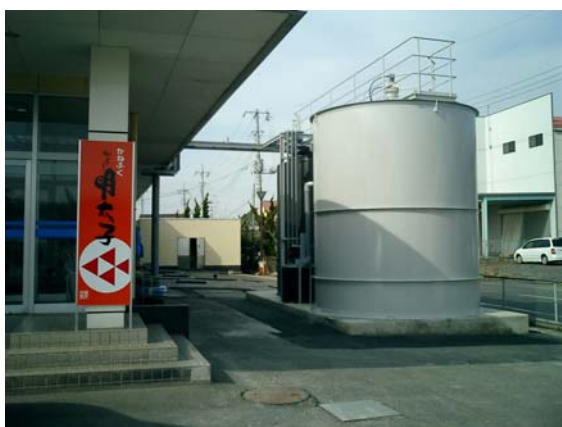
▲ 新設、沈殿槽及びNo6曝気槽
