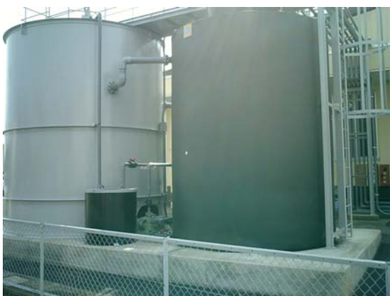
▲ 新設、沈殿槽及びNo6曝気槽
