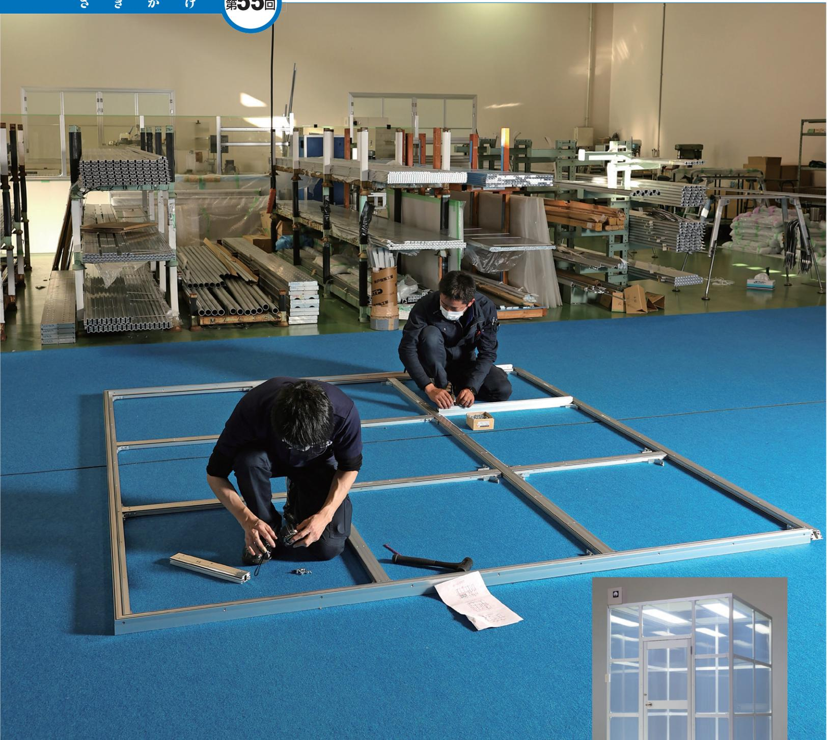
クリーンブースの骨格の仮組み。現場で組む前に、工場であらかじめ面ごとに組み上げ、接合部分の金具の具合などをチェックする。現場で組むときには問題が出ない状態にしておくことで、施工時間の短縮など効率アップにつなげる(完成形の写真は同社提供)
