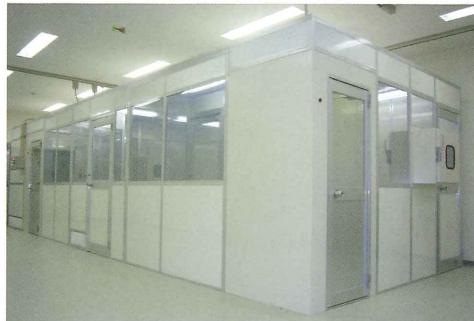
クリーンパネルと空調工事による大規模クリーンルーム（写真上）と、「KAMATAフレーム」を使用した大型クリーンブース（写真下）。
